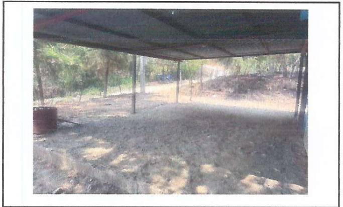
Foto 2: Mejoramiento instalacion piso torta de cemento.
