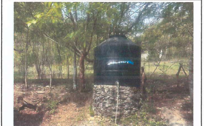
Foto 4: Mejoramiento e instalacion de lavamanos juntos a la base del tinaco.
