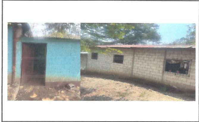
Foto 1: Mejoramiento instalacion de puerta metalica y ventanas de pvc.
